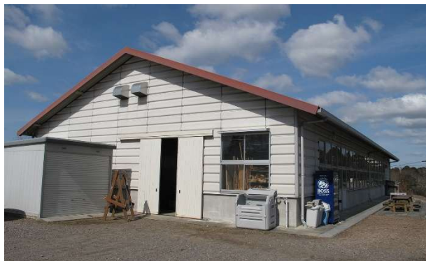
図1 旧実習棟外観
