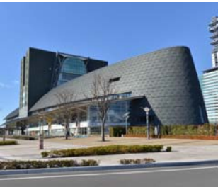
写真2 建物南面全景
