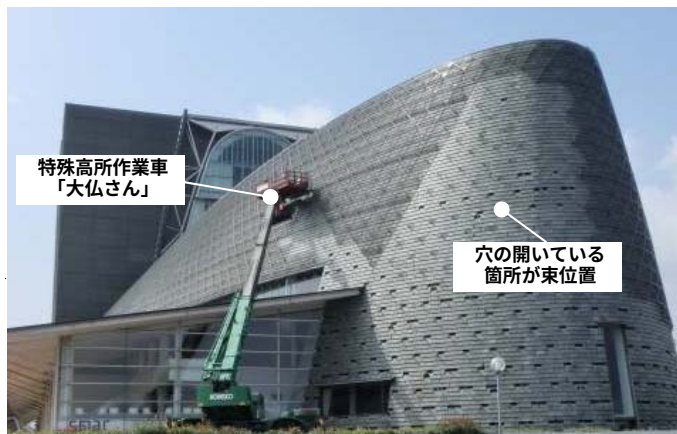
写真3 施工中：三角メッシュパネル取り付けと東部既設スレート取り外し状況
